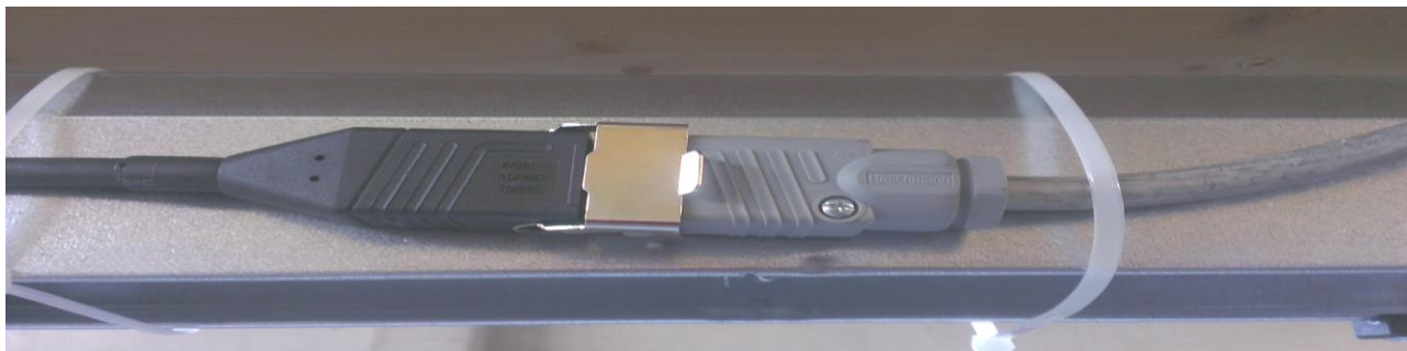
foto 1 - Dettaglio fissaggio corretto del cablaggio
