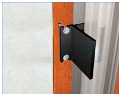
Profilo di fissaggio telaio infisso
